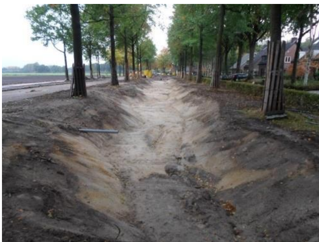
Figuur 5: Aanleg waterbergingsvoorzieningen Lange Trekken
