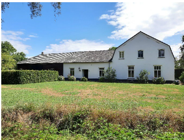
Straataanzicht van bedrijfswoning.
