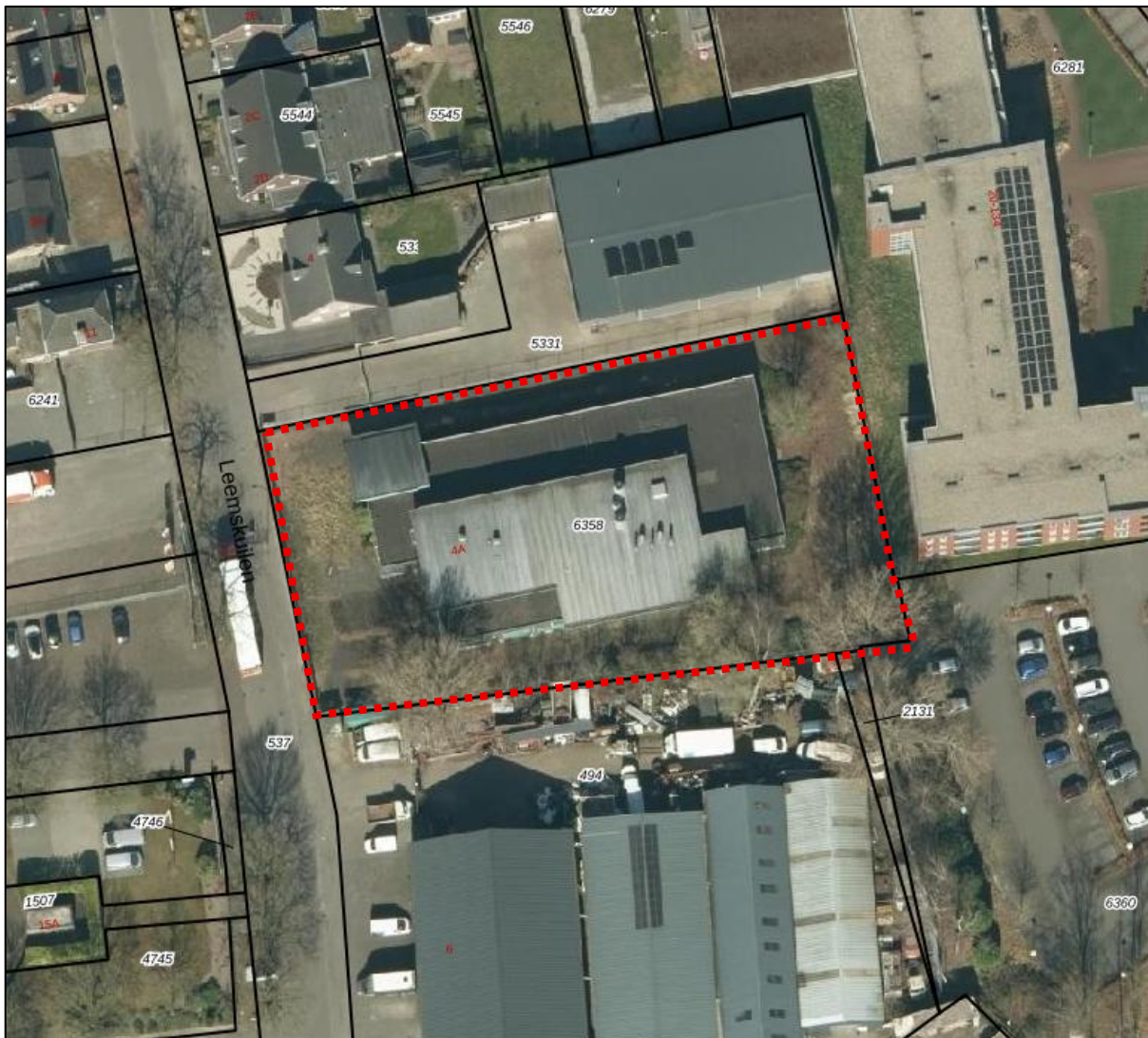
Figuur 2: Luchtfoto met kadastrale duiding plangebied (gronden behorende tot het plangebied zijn indicatief voorzien van een rode omlijning)
