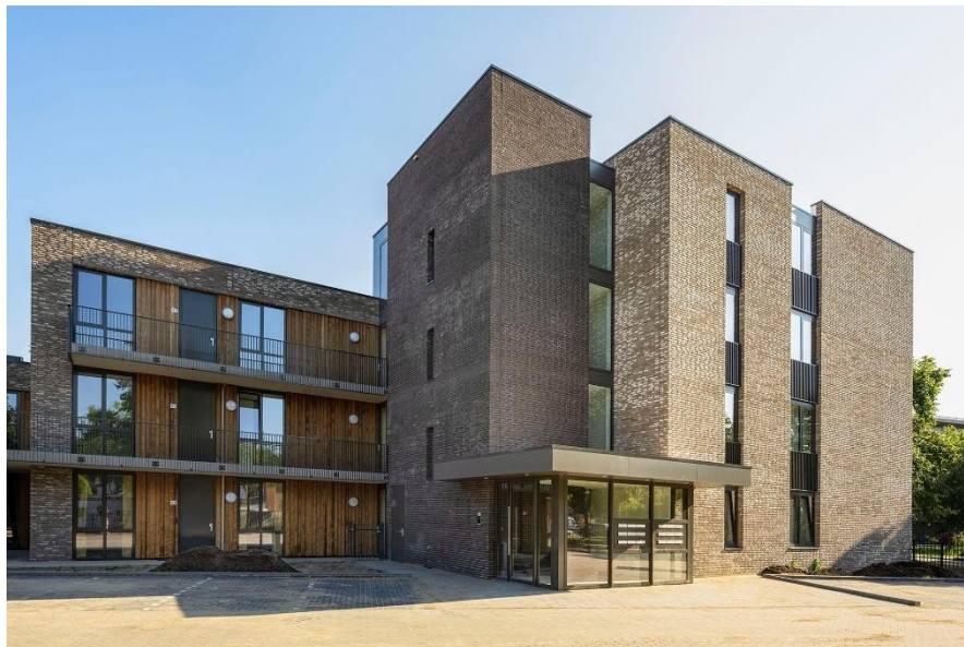
Duidelijke entree als accent in de gevel
