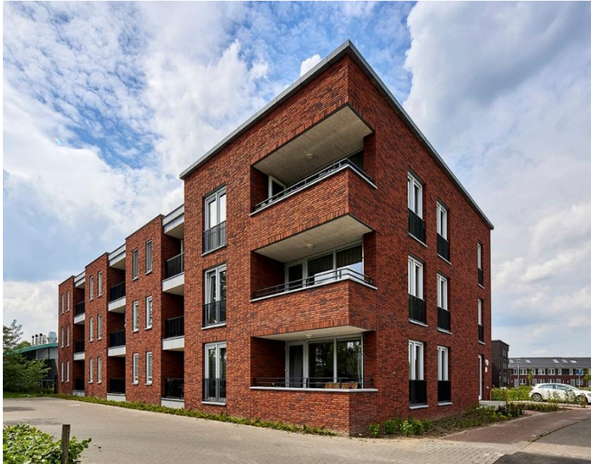
Gevelopeningen en verticaal lijnenspel
