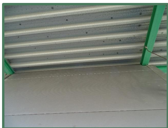
Foto 21: Strak aansluitende constructie.
