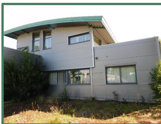
Foto 22: Geen openingen of kieren in de gevels. Ramen nog intact.
